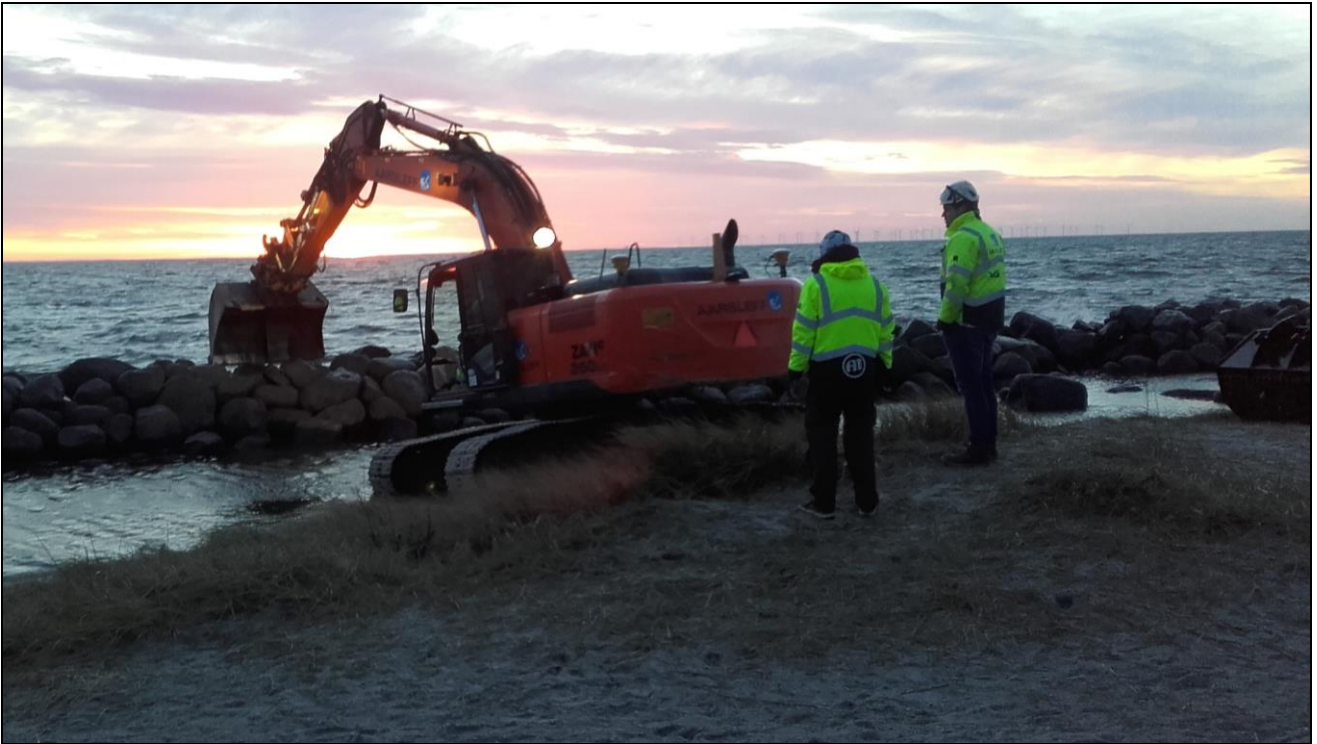
Opgravning på udvalgte dele af den østlige stenmole for undersøgelse af den nuværende opbygning og konstruktion. På billedet ses gravemaskinen (orange) samt ingeniør og projektleder fra A1 Consult A/S samt en repræsentant Per Aarsleff A/S, som ejer gravemaskinen.
